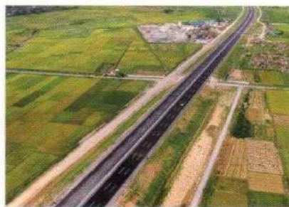
Dự án đường cao tốc Hà Nội - Hải Phòng Highway Hanoi - Haiphong
