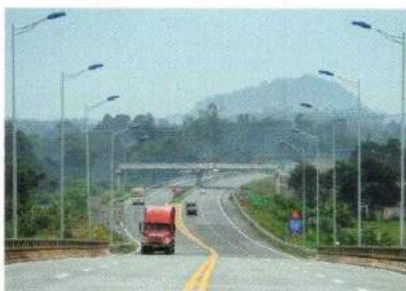
Dự án cao tốc Hà Nội - Lào Cai Highway Ha Noi - Lao Cai
